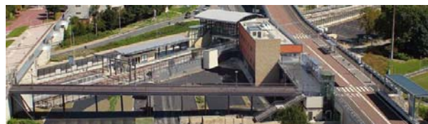
Nouvelle station Pointe du Lac Photo STIF-RATP
