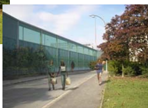
Requalification de la couverture acoustique A6b photos DIRIF
